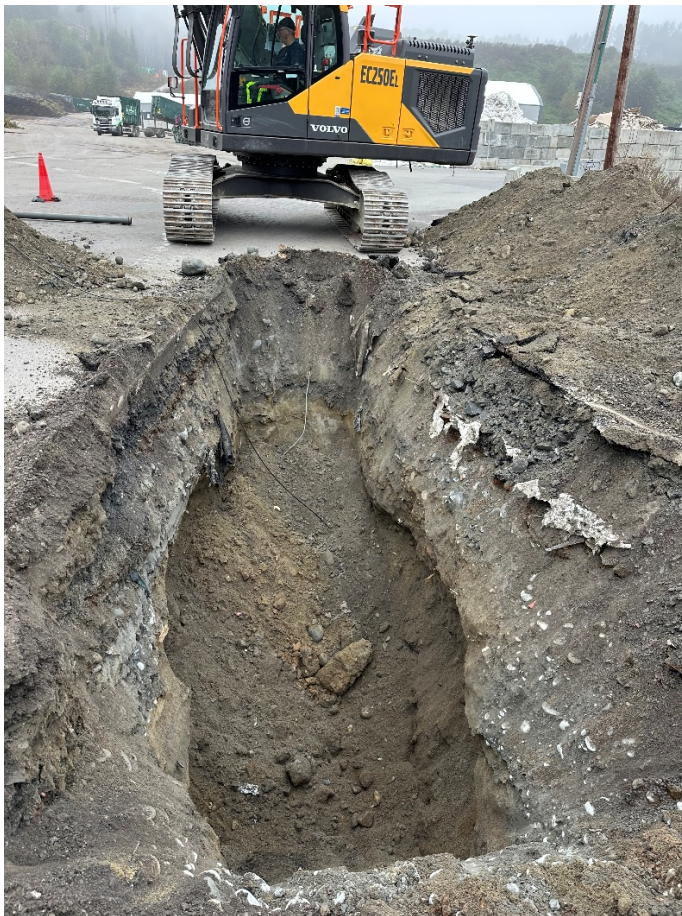
Foto 1: Prøvegrop P1 med gravedybde ned til 4,0 meter
